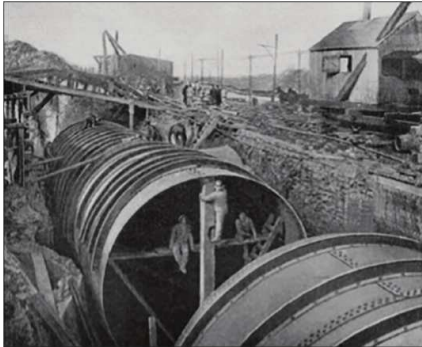
Figure 2: Conduit principal pendant la construction (Nunn, 1906)
