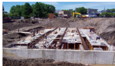
Construction of a reservoir / Construction d'un réservoir
