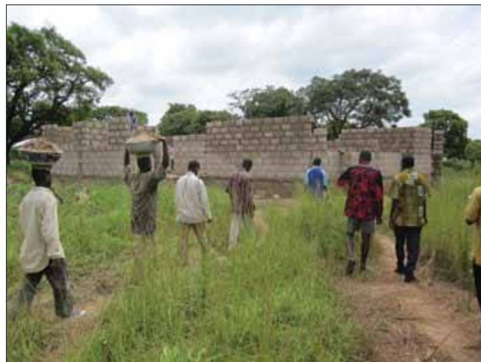
LEFT: Workers carrying sand to construct a Canadian International Development Agency (CIDA) funded teacher accommodation. / Travailleurs transportant du sable pour la construction d’un abri pour les enseignants, financé par l’Agence canadienne de développement international (ACDI).
