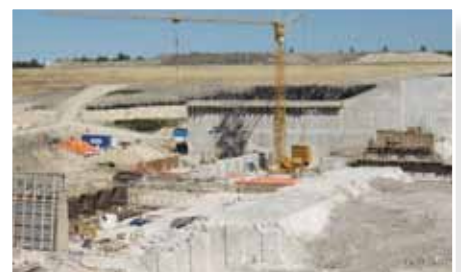
Above: At a cost of approximately $35 million, the expansion of the Outlet Control Structure was the single largest component of the Red River Floodway Expansion Project. As a result of the expansion, the Outlet will now be able to accommodate 140,000 cfs of water that would be flowing through the channel during a 1-in-700 year flood. / D'un coût d'environ 35 millions de dollars, l'expansion de la structure de contrôle de la décharge était le volet le plus important du projet d'expansion du canal de dérivation de la rivière Rouge. Suite à l'expansion, la décharge pourra dégorger jusqu'à 140 000 pi 3 /s, un événement susceptible de se produire 1 fois en 700 ans.
