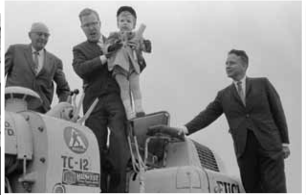
Above: At the official groundbreaking for the floodway on October 6, 1962, former Manitoba Premier Duff Roblin lifts his son onto an earth scraper used to turn the first sod to begin construction on the Red River Floodway. Also in the picture is S.V. Sigurdson, Head of Monarch Construction (Left), and Walter Dinsdale, Natural Resources Minister (Right). / Lors du début de la construction du canal de dérivation, le 6 octobre 1962, l'ancien Premier ministre du Manitoba, Duff Roblin, fait grimper son fils sur une machine qui va amorcer la construction. On reconnaît également sur la photo S.V. Sigurdson, patron de Monarch Construction (à gauche), et Walter Dinsdale, ministre des Richesses naturelles (à droite).
